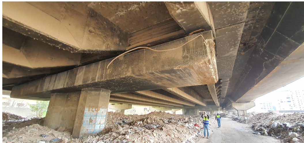
Intradosso di viadotto a Giza
