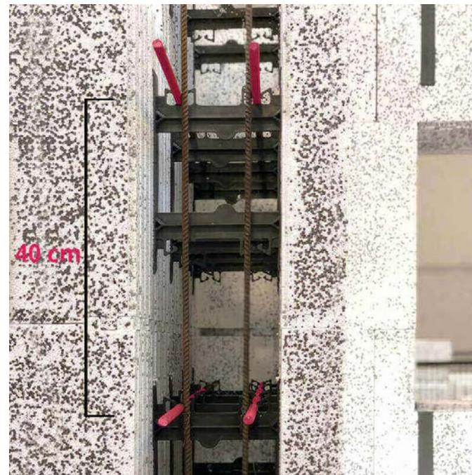
Nelle pareti in c.a. realizzate con i casseri Climablock, le armature orizzontali possono essere disposte con passo 40 cm che è il massimo consentito dalla norma. Da ciò ne conseguono importanti vantaggi quali una minor quantità di armatura e minor tempo di posa necessari per la realizzazione della struttura con conseguente ottimizzazione di costi e tempi di cantiere.
