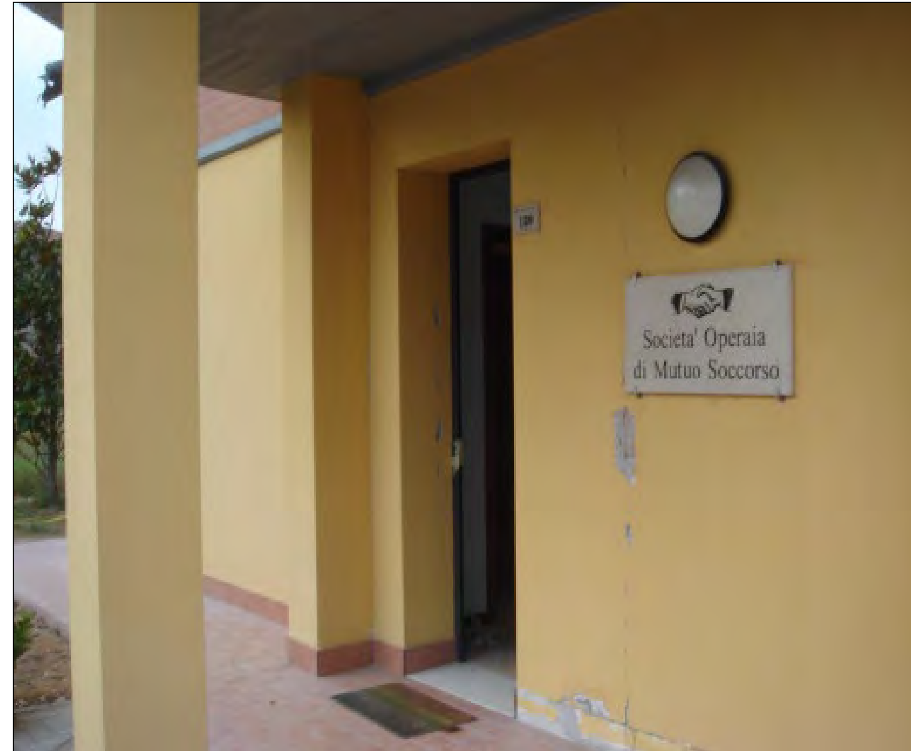
Traccia dei pilastri sui tamponamenti esterni
